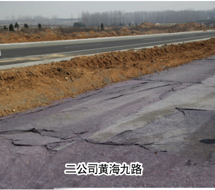
水稳基层养护采用土工布等缝合工艺
