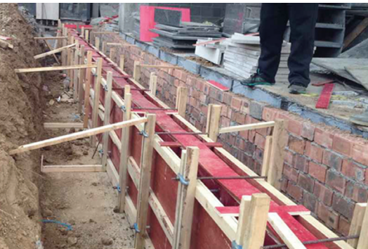
北斗公司：辰坤国际线性排水沟模板支设规范
