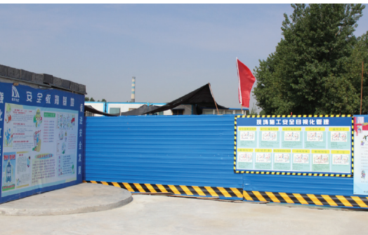
一公司：陷泥河疏浚工程临边防护、文明施工措施到位
