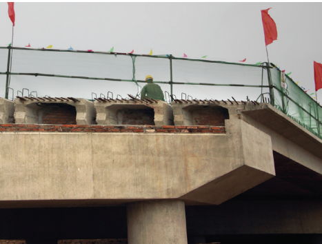
七公司：341 涛坪线临边防护规范到位
