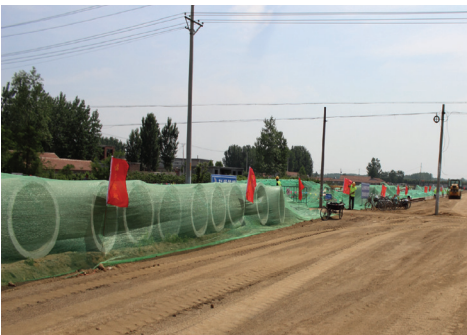
六公司：中环北线安全警示、文明施工措施到位
